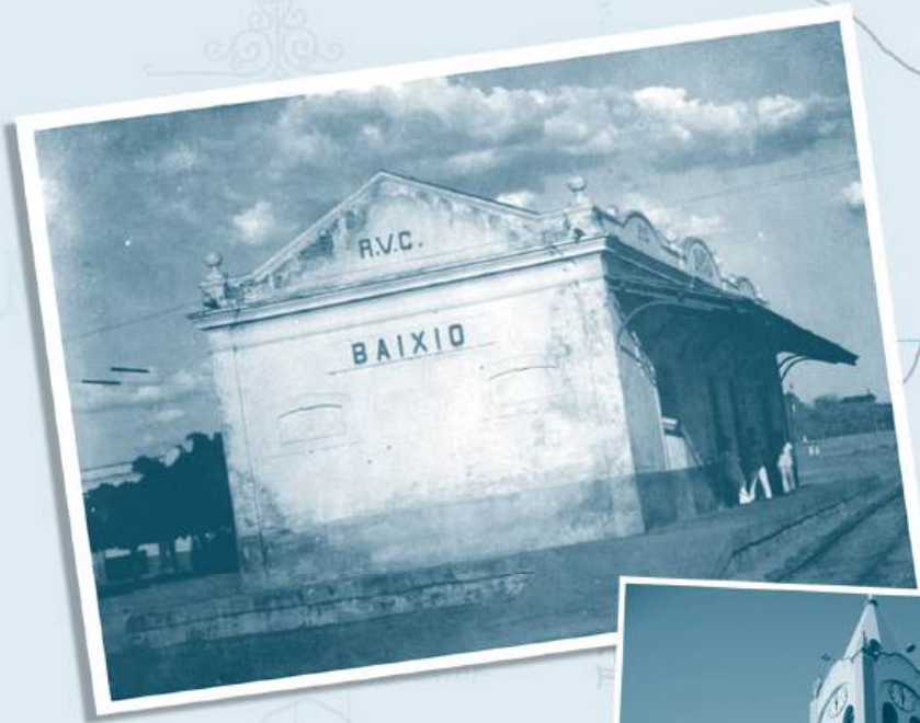
Estação Ferroviária em Baixio
